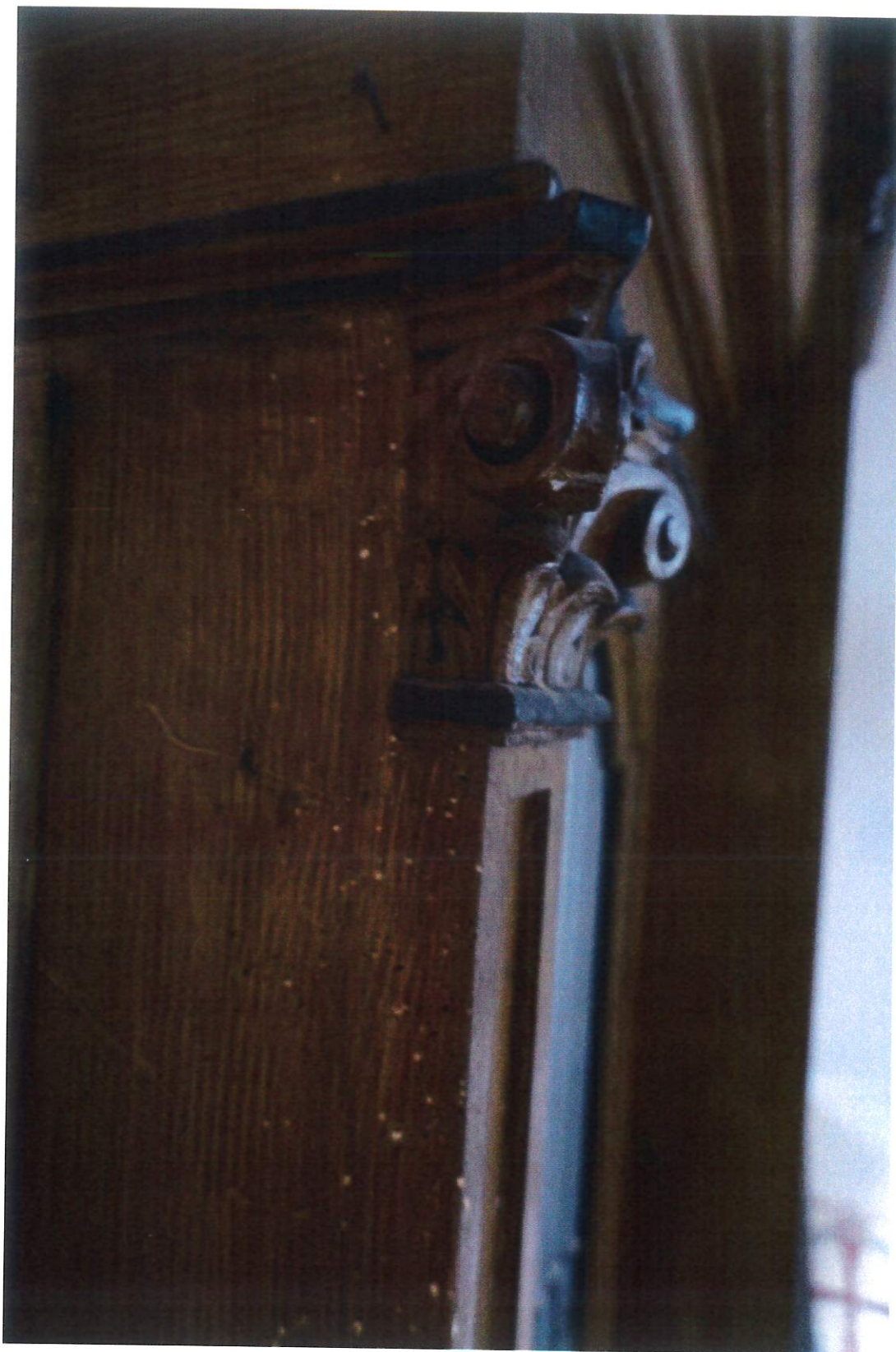
Fot.5. Grodzisko, Kościół pw. Wniebowzięcia NMP i św. Józefa Rzemieślnika, Prospekt organowy. Widok na detal prospektu. Widoczne otwory po drewnojadach, zabrudzenia i przebarwienia powierzchni. Stan przed konserwacją.
