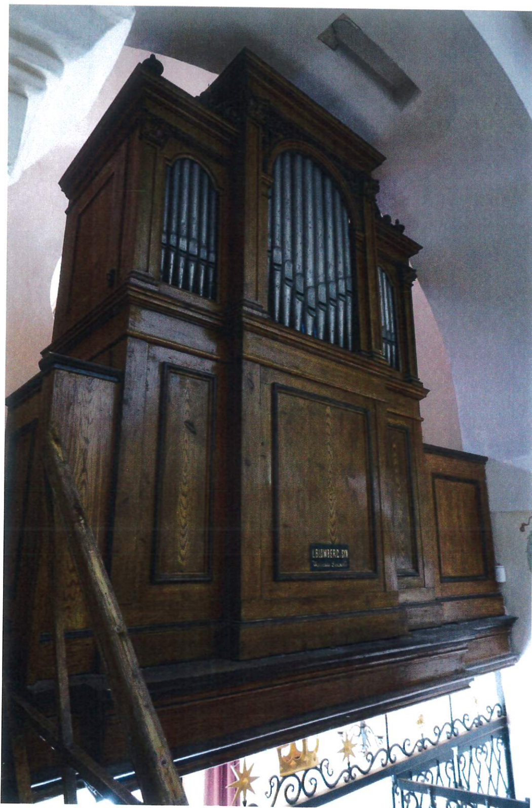
Fot.2. Grodzisko, Kościół pw. Wniebowzięcia NMP i św. Józefa Rzemieślnika, Prospekt organowy. Widok ogólny na prospekt. Widoczne zabrudzenia i przebarwienia powierzchni. Stan przed konserwacją.
