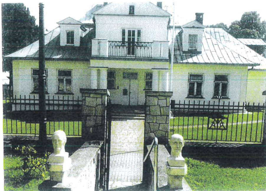
Fot. 3 Budynek parafialny kościoła p.w. , Matki Boskiej Różańcowej w Smardzowicach, przy ul. Kościelnej 12. Rok 2023, stan istniejący obiektu, przed konserwacją. Elewacja frontowa, południowa, widok od strony płd.
