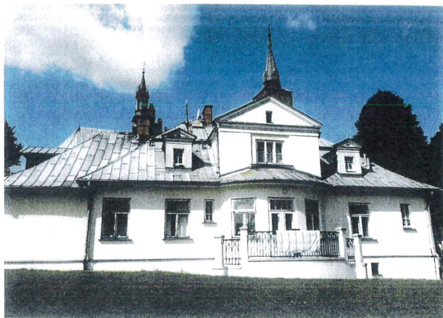
Fot. 2 Budynek parafialny kościoła p.w. , Matki Boskiej Różańcowej w Smardzowicach, przy ul. Kościelnej 12. Rok 2023. stan istniejący obiektu, przed konserwacją. Elewacja frontowa, północna, widok od strony ogrodu płn.
