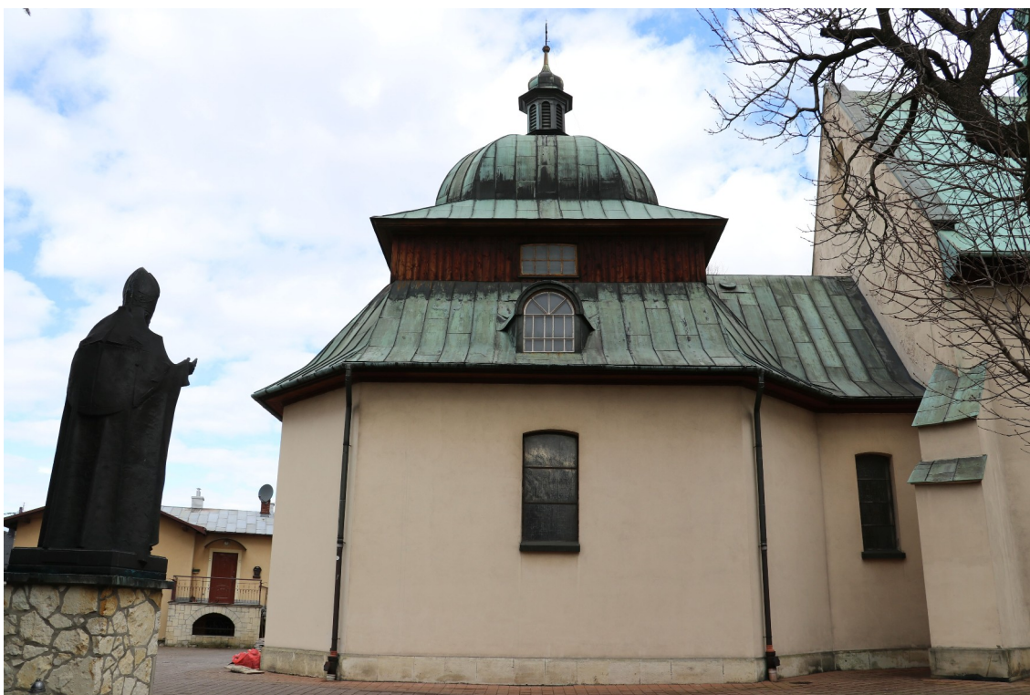
fot. 8: Elewacja południowa kaplicy-widok ogólny.
