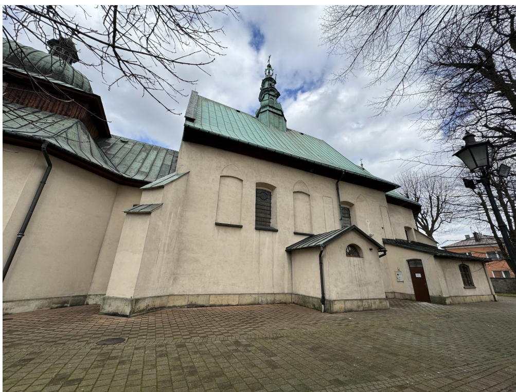
fot. 1: Elewacja południowa-widok ogólny.
