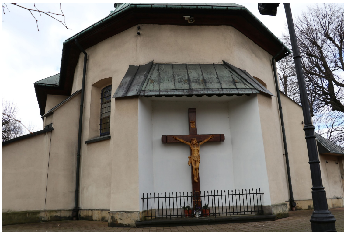
fot. 23: Elewacja wschodnia-widok ogólny.
