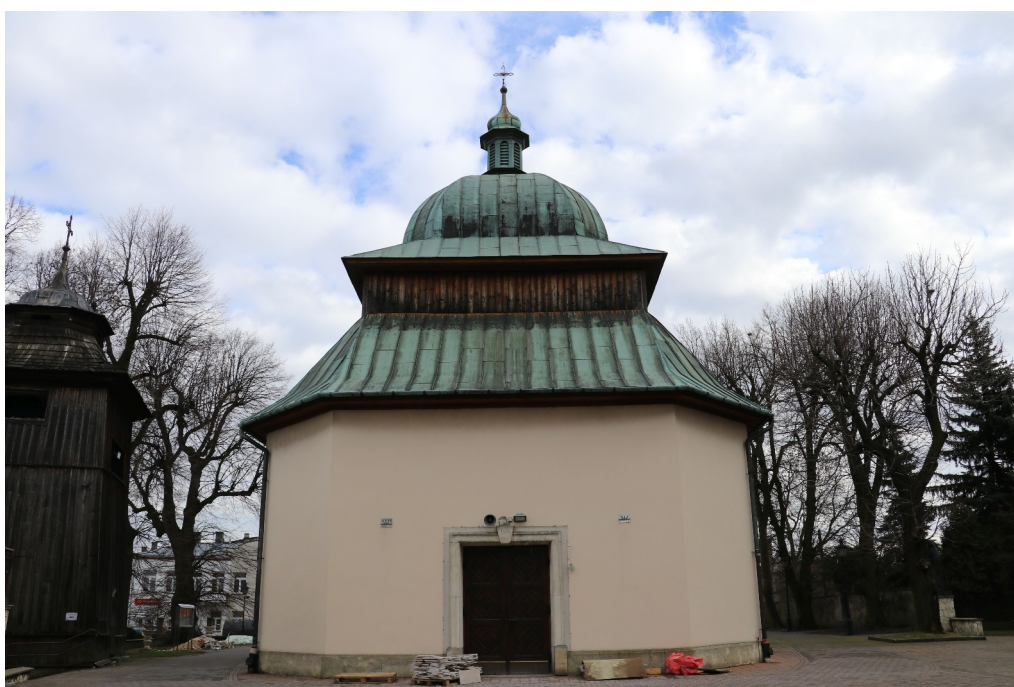
fot. 2: Elewacja zachodnia-widok ogólny.
