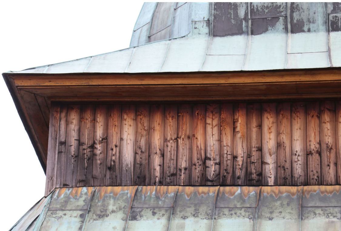
fot. 6: Zszarzałe drewno deskowania szalunkowego.
