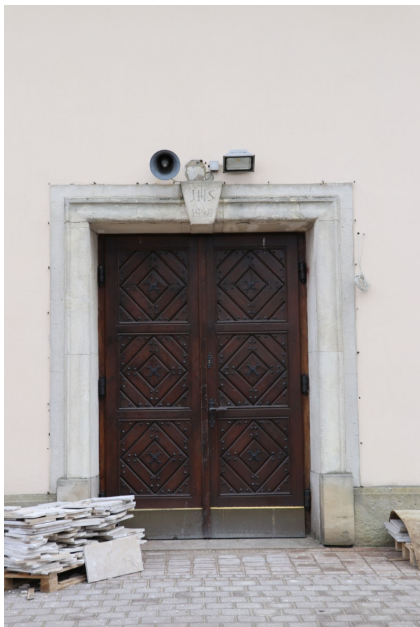
fot. 3: Oprawa kamienna wejścia elewacji zachodniej.
