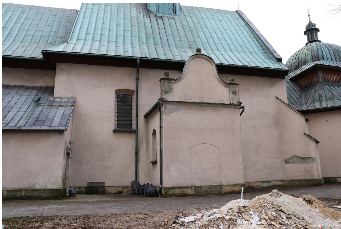
fot. 27: Fragment elewacji północnej-widok ogólny.
