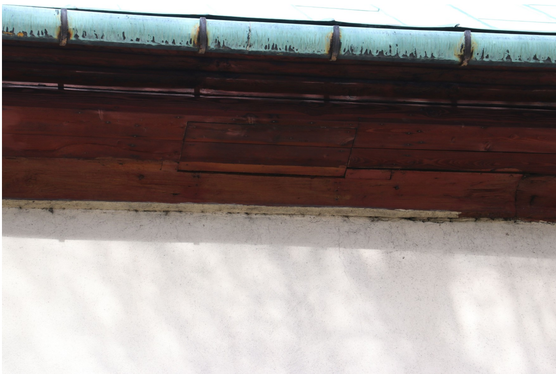
fot. 16: Podbitka drewniana pod okapem dachu korpusu kościoła.
