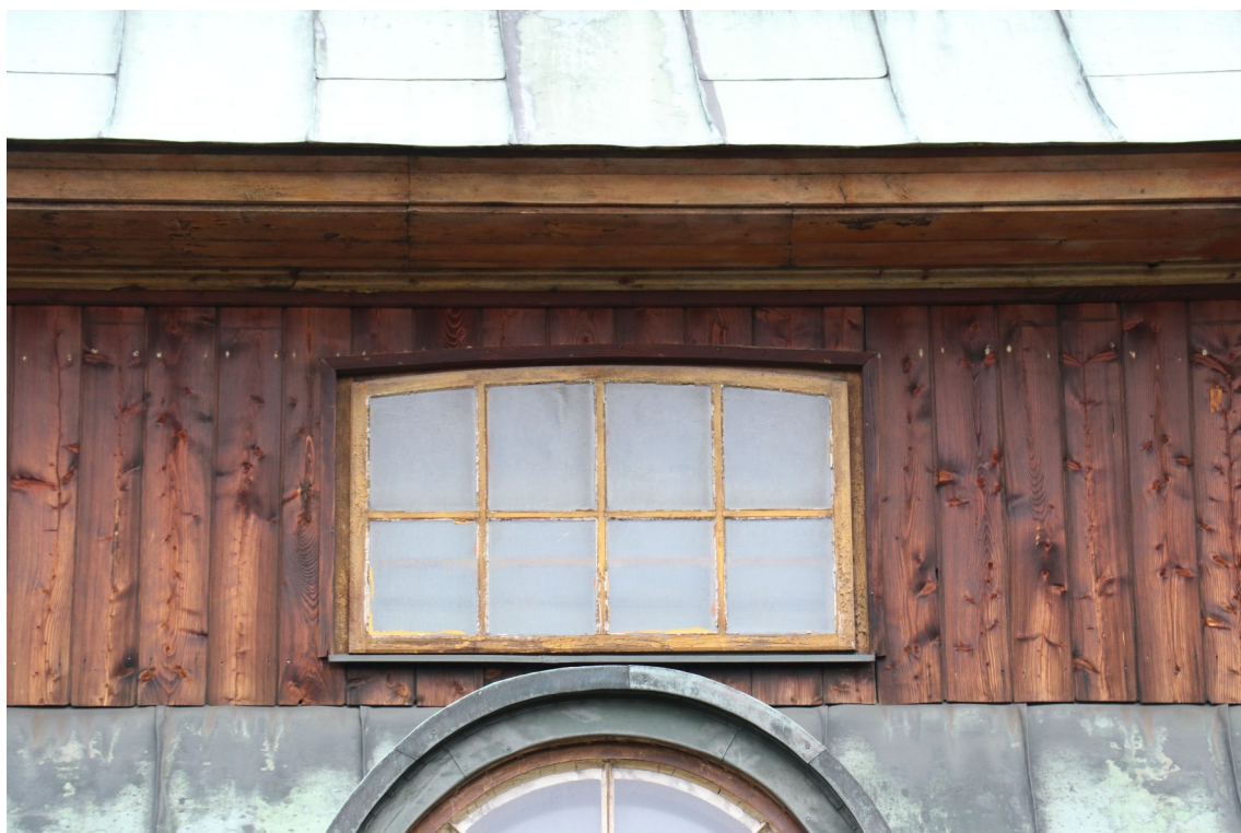
fot. 7: Widoczne gwoździe montażowe desek szalunkowych.
