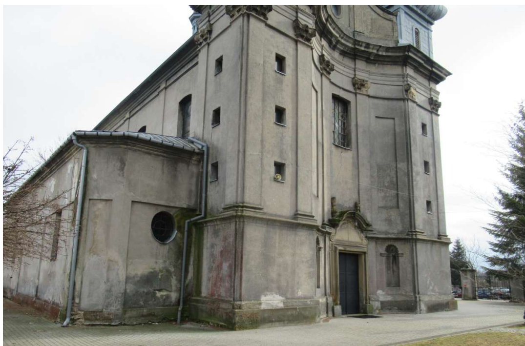
Fotografia nr 7. Elewacja północna, zachodnia
