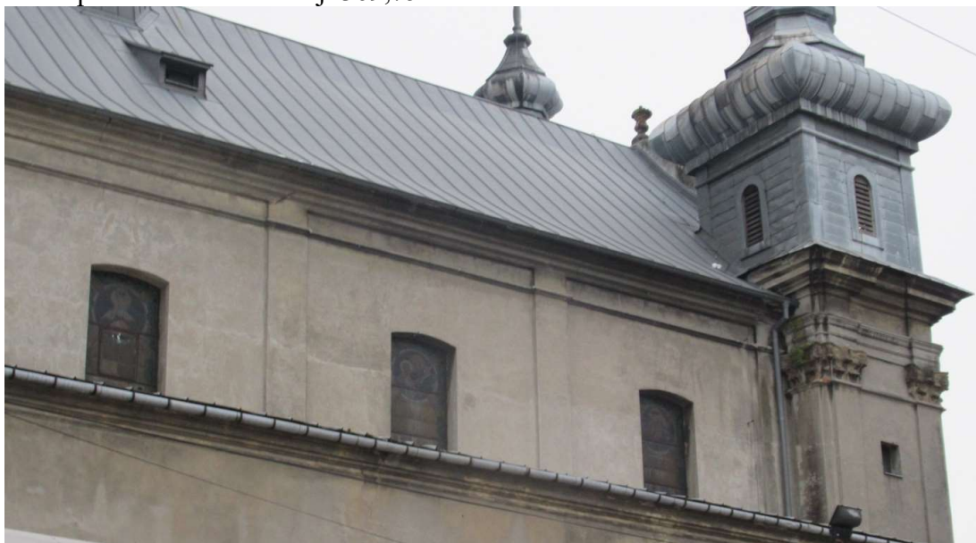
Fotografia nr 7. Elewacja północna
