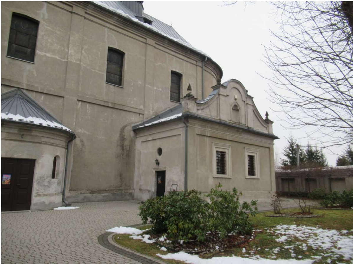
Fotografia nr 3. Elewacja południowa
