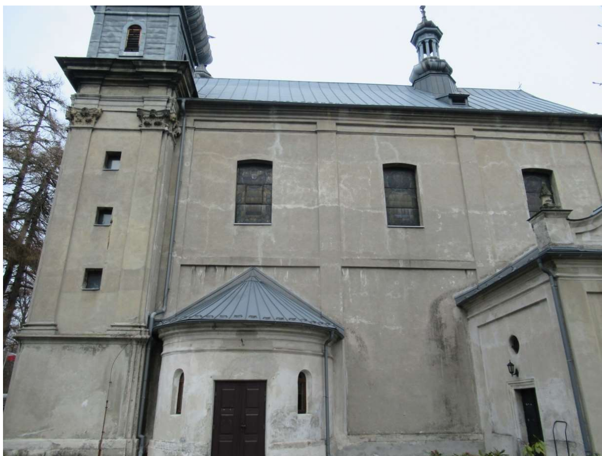
Fotografia nr 2. Elewacja południowa
