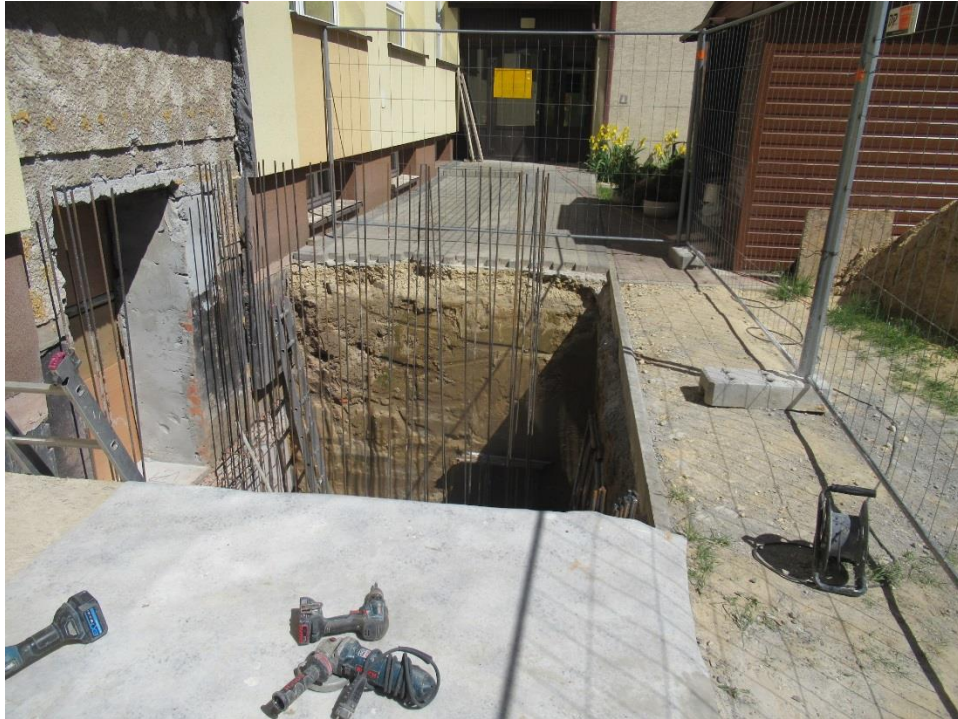
Budowa windy w Szkole Podstawowej w Minodze
