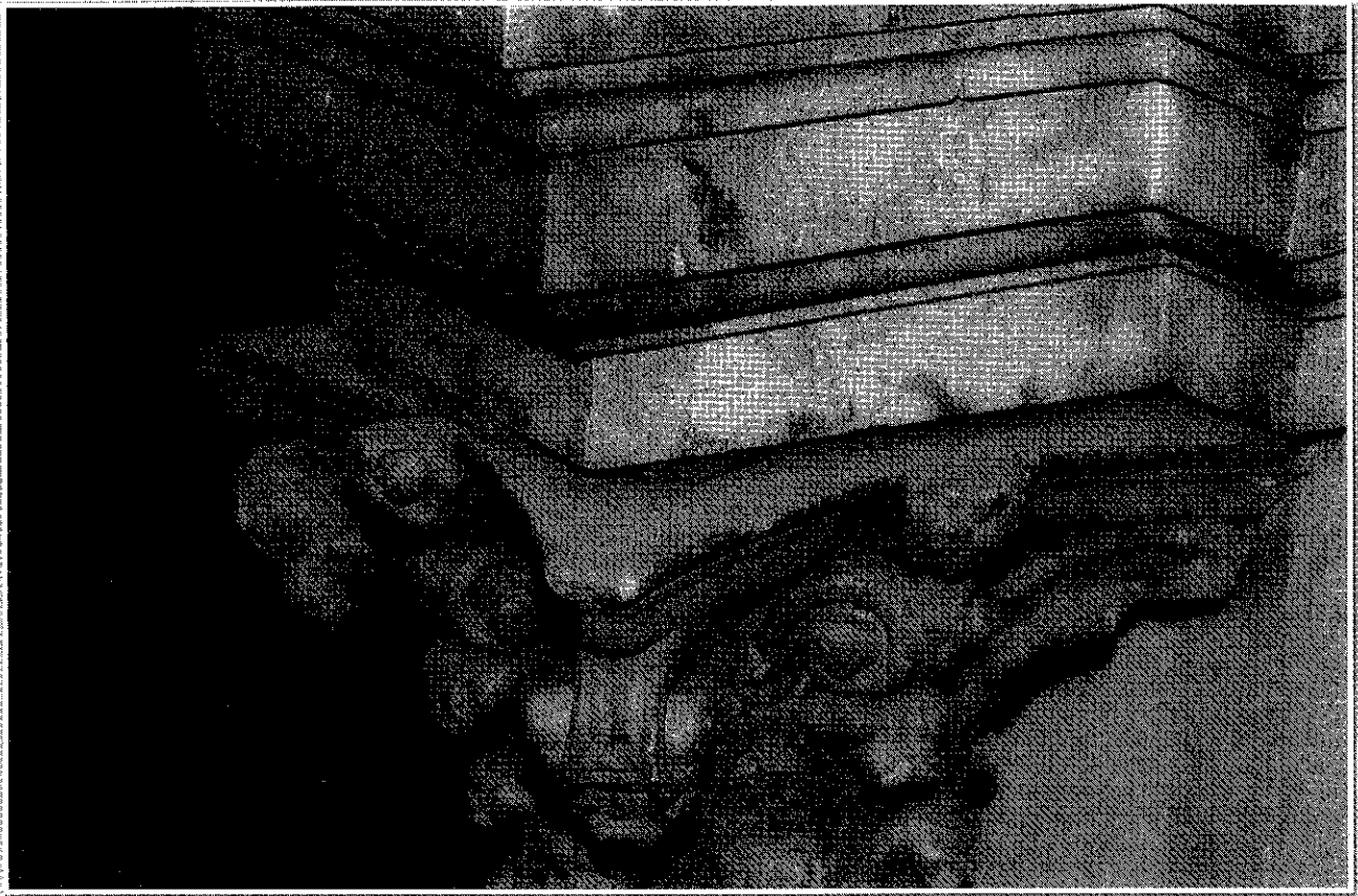
Fot. 5.1.27. Grodzisko 7, 32-043 Skała, kościół p.w. Wniebowzięcia NMP i św. Józefa Rzemieślnika, OŁTARZ BŁ. SALOMEI. Stan zachowania detalu architektonicznego. Prowizoryczne uzupełnienie szczeliny drewnem. Fot. J. Kunert, listopad 2017.
