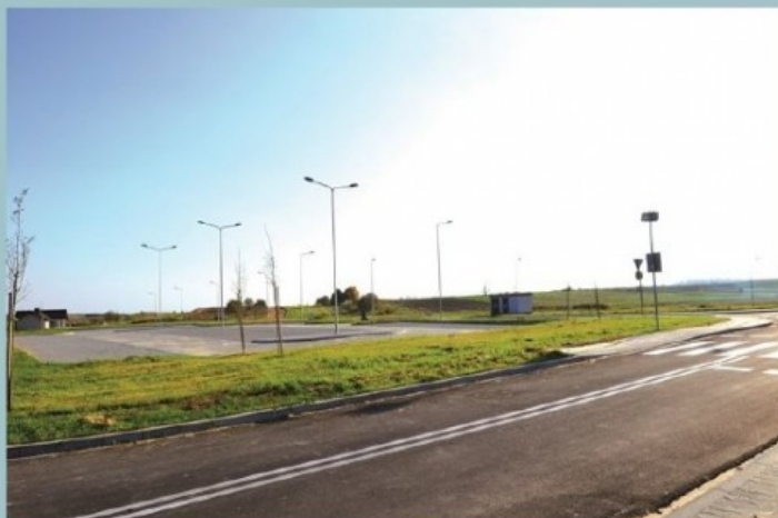
Zdjęcie nr 1 Parking na Strefie Aktywności Gospodarczej w Skale
