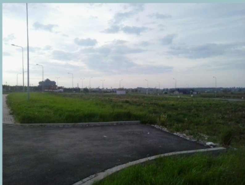
Zdjęcie nr. 3 Zdjęcie Infrastruktury SAG w Skale.
