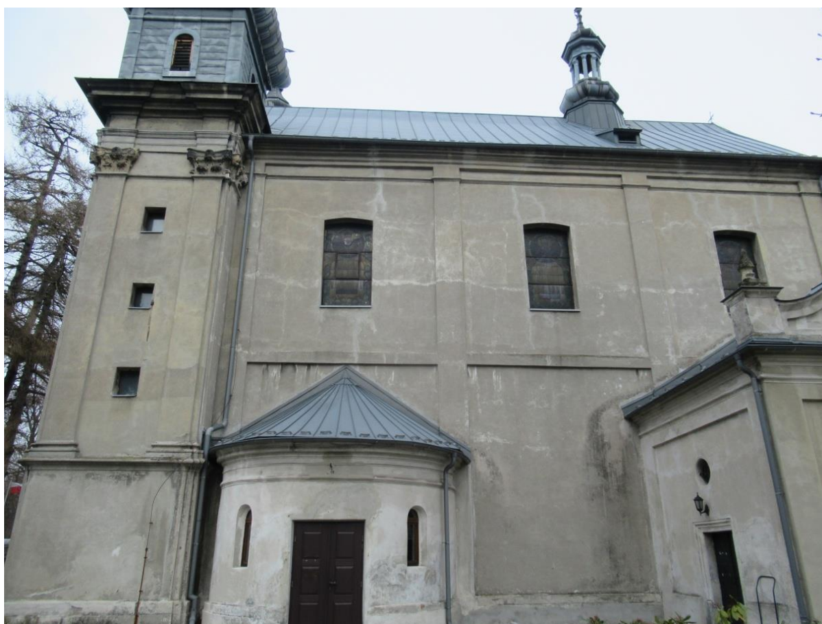
Fotografia nr 2. Elewacja południowa
