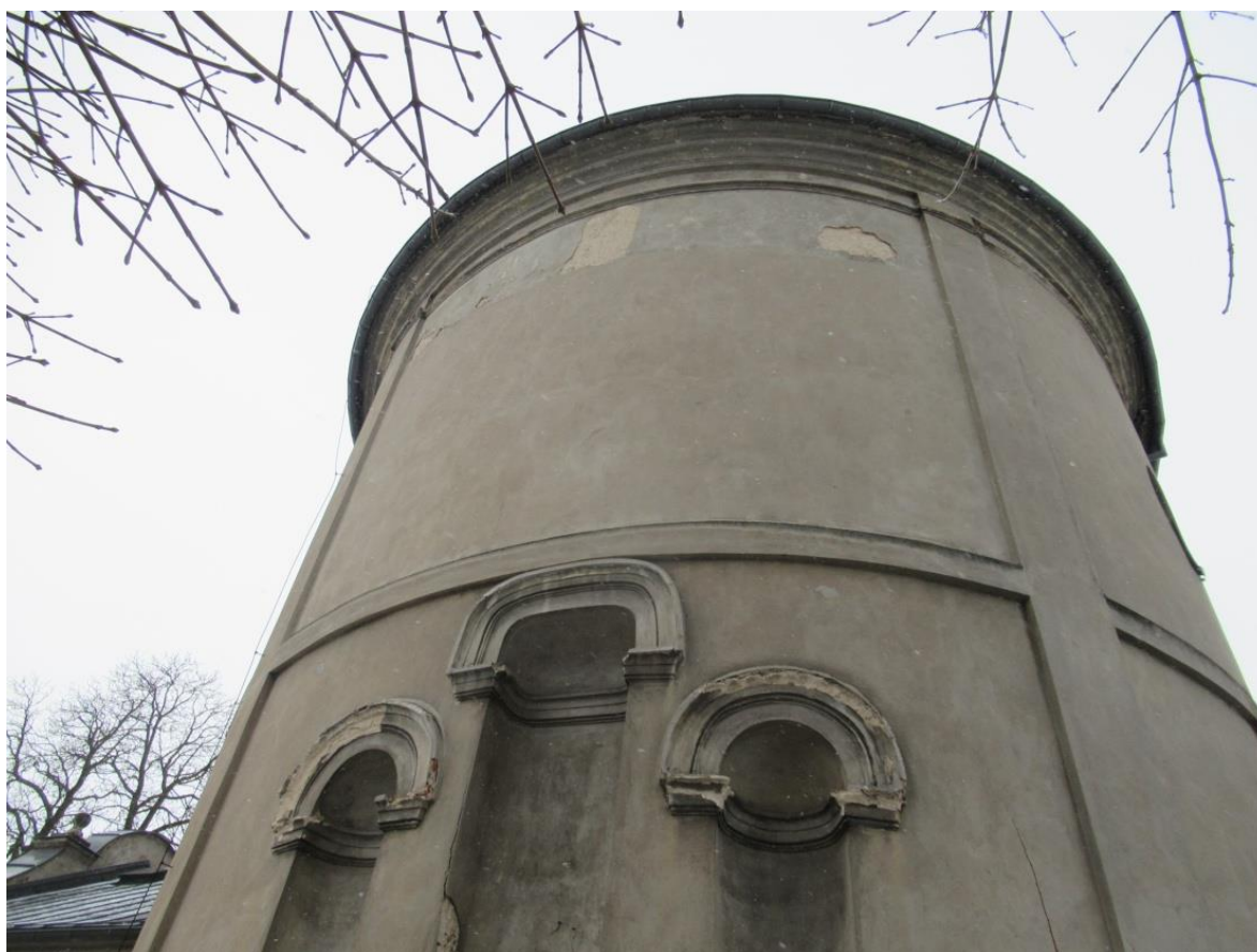
Fotografia nr 4. Elewacja wschodnia
