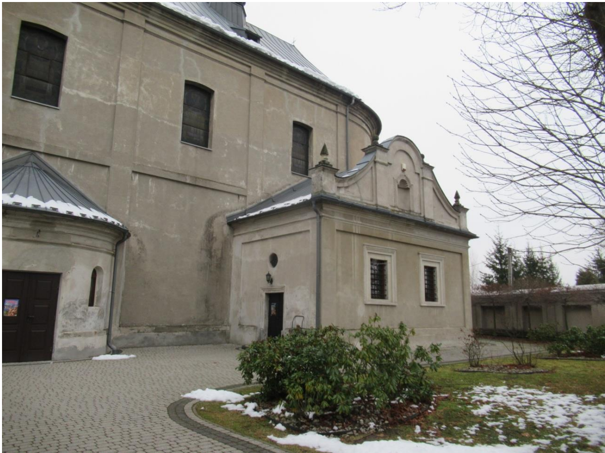
Fotografia nr 3. Elewacja południowa
